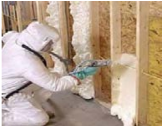
عایق‌بندی با نوعی فوم خمیری
