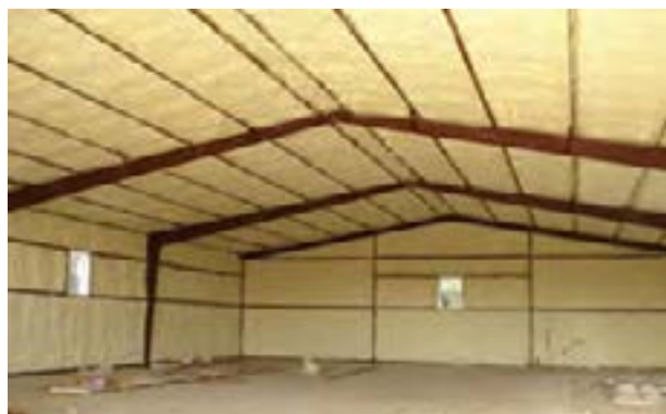
عایق‌بندی سقف و دیواره
