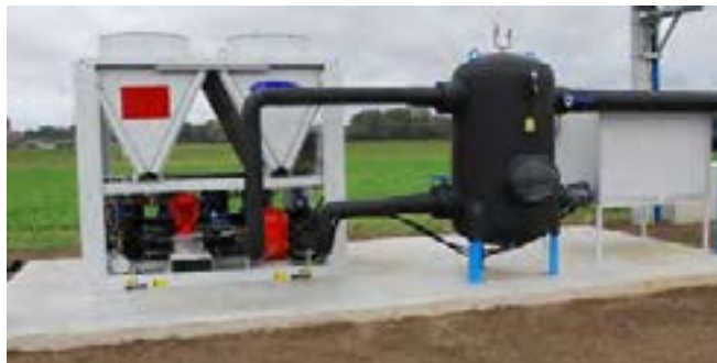
سیستم خنک‌کننده یک تولیدی قارچ دکمه‌ای
