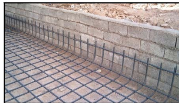
(آرماتورهای تحتانی فونداسیون)
