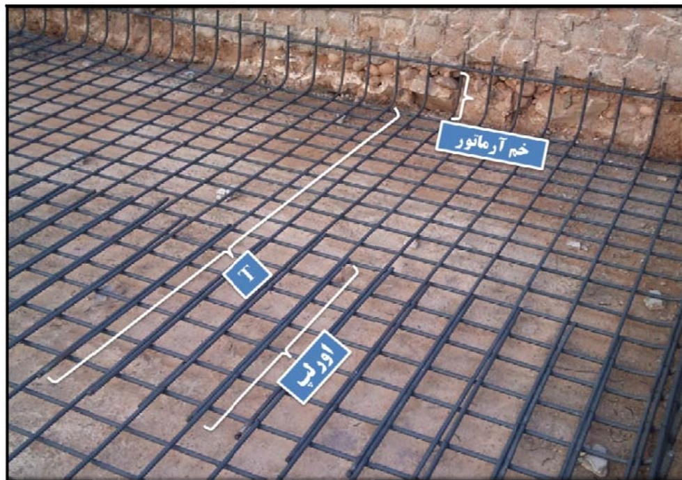
(آرماتورهای تحتانی فونداسیون)
