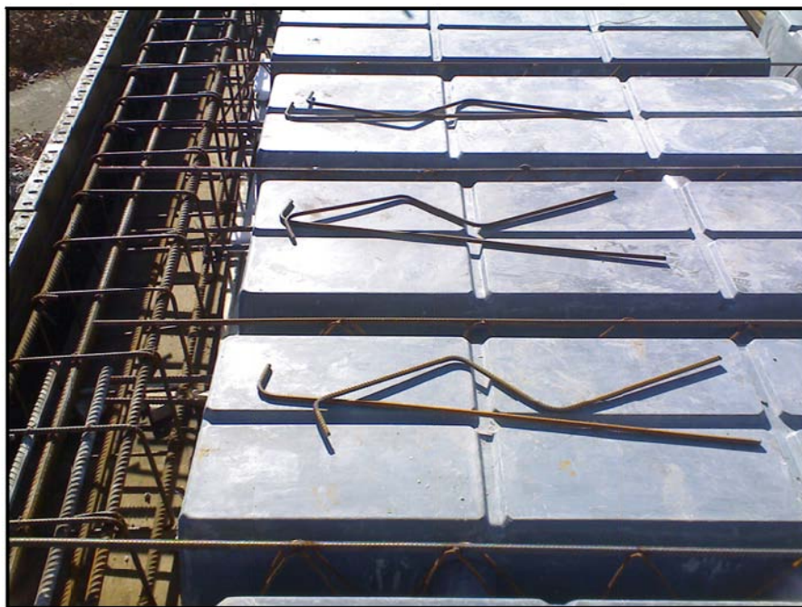
(آرماتور اوتکا یک طرفه در تیر بتنی)
